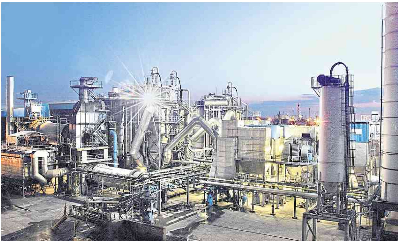
Der Westerwälder Anlagenbauer Steuler wird im Rotterdamer Hafen eine Rauchgasreinigungsanlage bauen. Das Unternehmen hat kürzlich den Zuschlag für den 17-Millionen-Euro-Auftrag erhalten. Zwischen 2006 und 2008 hatte Steuler im Hafen eine Anlage kleineren Typs gebaut (Foto). Foto: Steuler Anlagenbau
